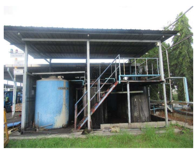
ภาพที่ 12 บ่อพักน้ำทิ้งจากกระบวนการผลิต
